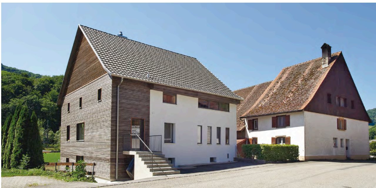
Maison Burri à Soyhières – façade nord avec nouvelle entrée au bureau
