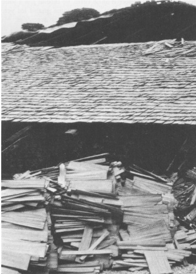
Bardeaux à poser et toiture en rénovation (photo Gilbert Lovis).
