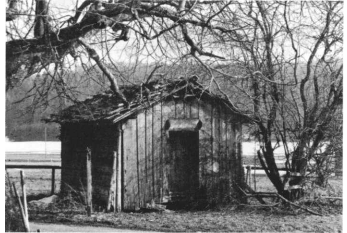
Photo 1 - Le grenier traditionnel avec son «enveloppe de planches».
