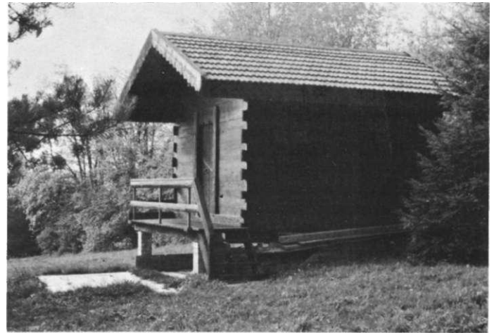
Photo 2 - Exemple de grenier transformé en maisonnette de vacances; l'habituelle protection de planches n'existe plus.
