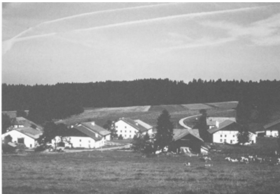
A part trois «mal tournées», toutes les fermes de La Bosse sont à façade-pignon principale et abritées du typique toit à deux pans sur murs gouttereaux est et ouest.
