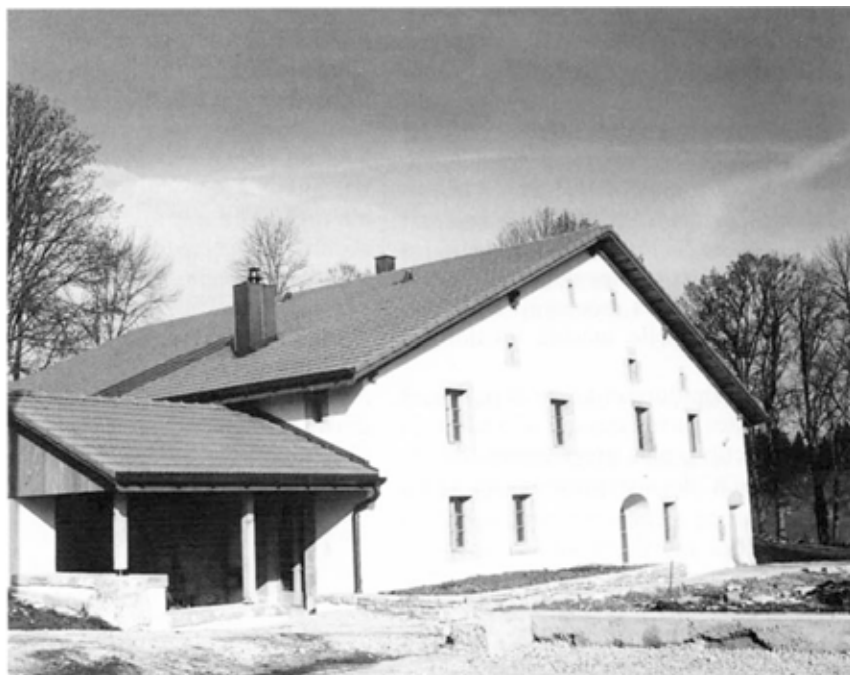
Après 1993: la façade, sud n'a subi aucune modification. L'annexe a été ajoutée.
