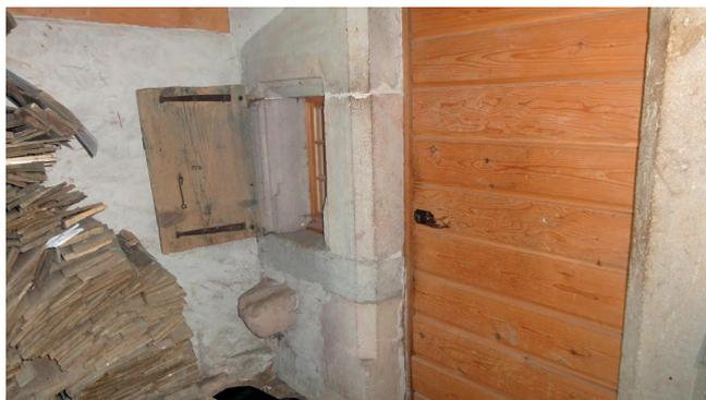
Figure 17 Le volet de la cuisine et l'écoulement de l'évier.
