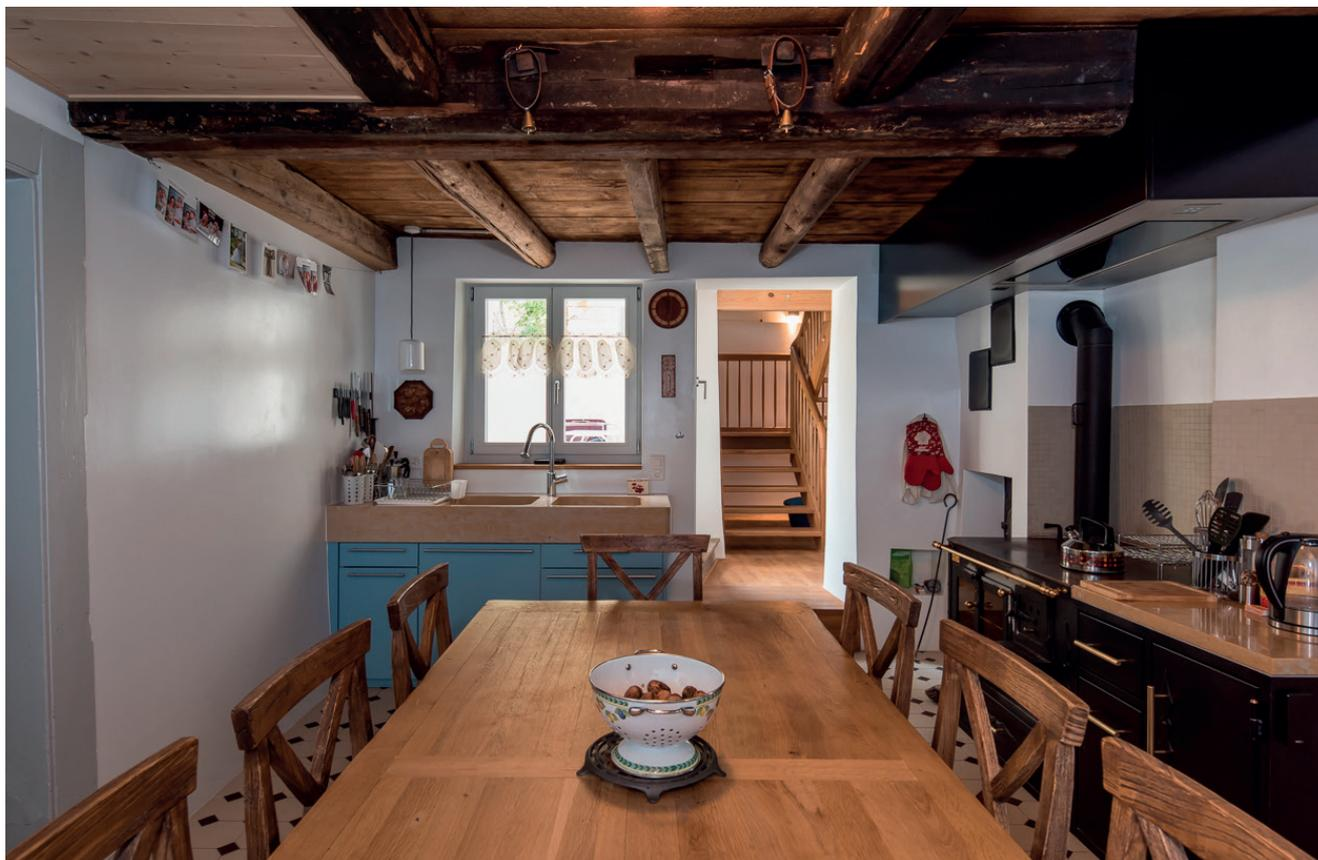
**Figure 9** La cuisine après rénovation : les faux-plafonds ont été enlevés pour laisser apparaître planches et poutres noircies par la fumée. En revanche, le plancher de la cuisine n'a pas pu être conservé car en trop mauvais état. Il a été remplacé par un nouveau carrelage en grès. (Photographie d'Adrien Barakat, 2017)
