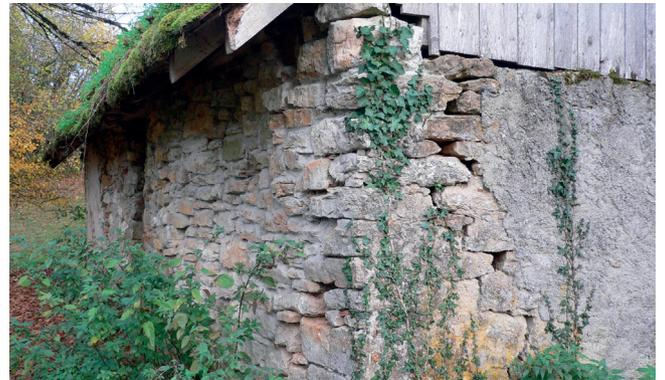
Figure 45 5-02 Loge en mauvais état. (Photo N. Gogniat, 2015)
