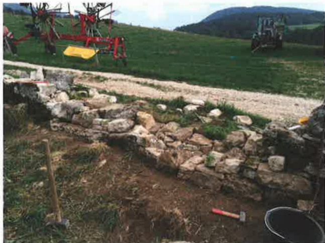
Figure 6 : Les pierres de construction sont posées sur les pierres de fondation, il n'y a plus d'espace, aucune pierre ne bouge. (Nods, septembre 2016, photo Moussia de Watteville)
