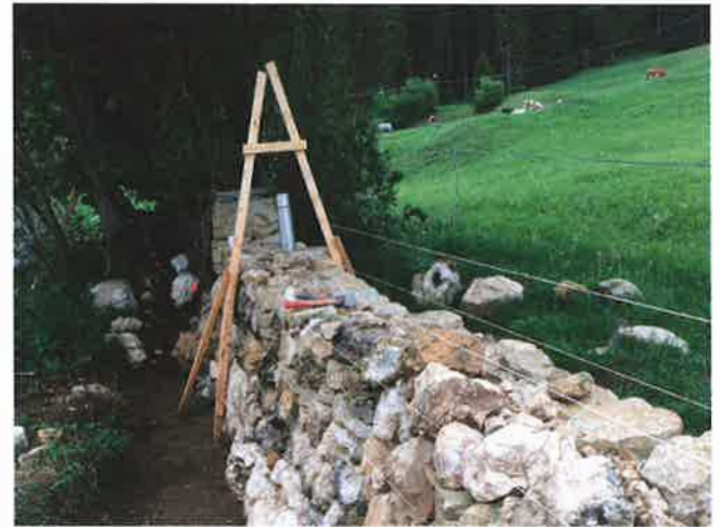
Figure 9 : La dernière couche est préparée pour accueillir ensuite les couvertines. On voit ici les fils qui servent à respecter le fruit du mur ainsi que sa hauteur. Ils gênent souvent, mais ils sont indispensables. (Malleray, été 2017, photo MdW)
