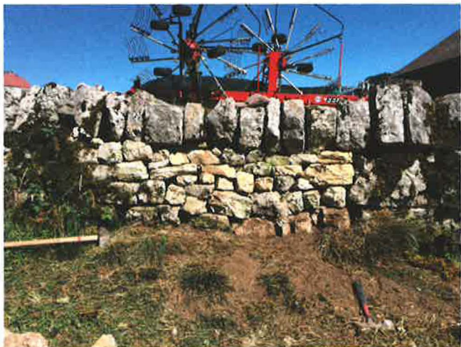
Figure 10 : Réparation d'un mur terminée. (Nods, septembre 2016, photo MdW)
