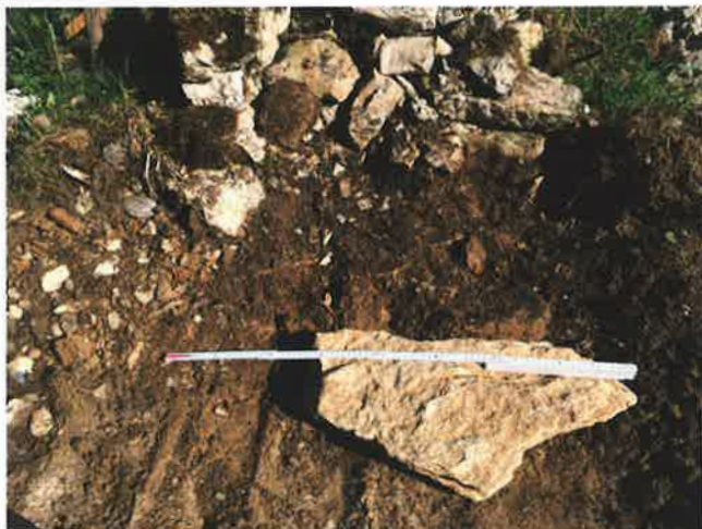
Figure 2 : Les machines ont démonté le mur et préparé grossièrement la base, le terrain est reconditionné de manière plus précise à la main, en sorte d'une largeur adaptée à la moitié de la hauteur. Les pierres de fondation sont choisies. (Mont-Crosin, été 2016, photo Moussia de Watteville)
