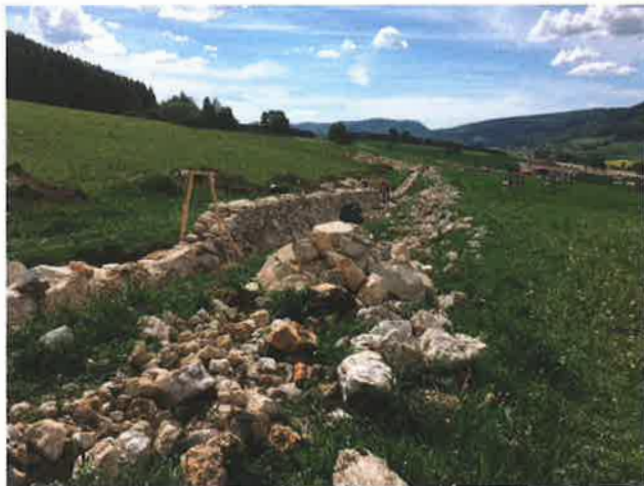
Figure 7 : Les muretiers travaillent en principe chacun de leur côté. Le mur monte en même temps de chaque côté. On s'aide, on se parle, on s'arrange pour placer ensemble des pierres « traversantes », celles qui traversent le mur de part en part. (Malleray, été 2017, photo Moussia de Watteville)
