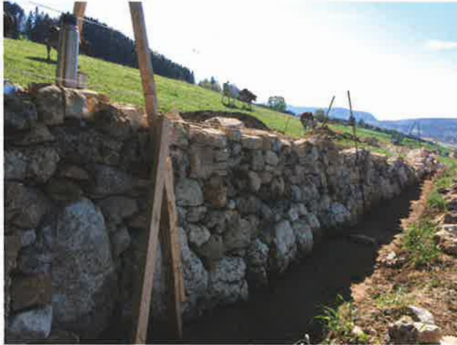
Figure 8 : Le gabarit pourra bientôt être enlevé, le mur a presque atteint la hauteur désirée. (Malleray, été 2017, photo Moussia de Watteville)
