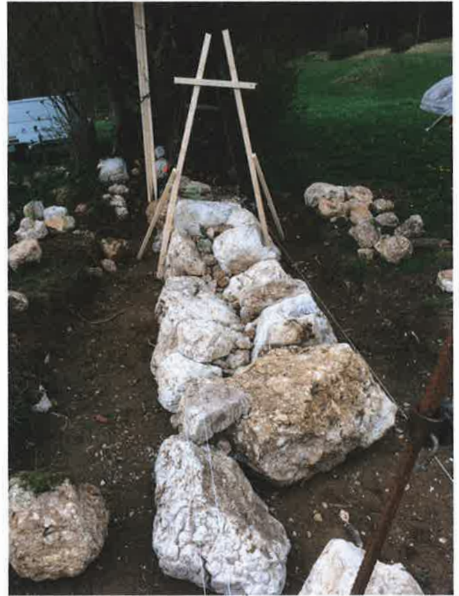
Figure 5 : Après s'être occupé des faces du mur, on remplit l'intérieur du mur, d'abord avec les plus grosses pierres possible, puis avec du plus petit matériel. (Malleray, été 2017, photo Moussia de Watteville)
