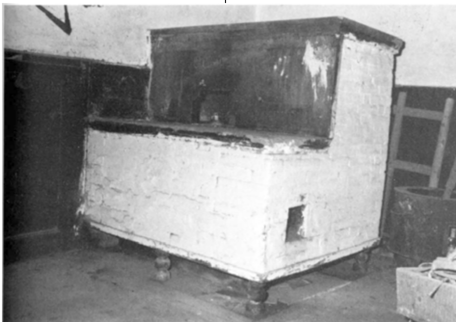
Ancien fourneau en briques, avec banc, dossier et fermeture supérieure en molasse.
