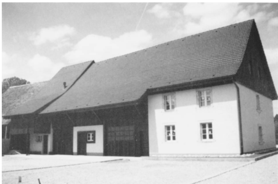
Alle: Ferme Jaggi, sur la route de Courgenay. Rénovée 1992-1993.
