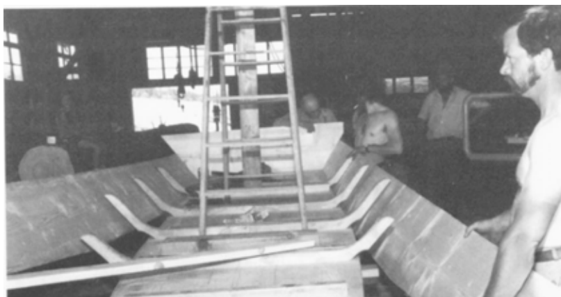
Une barque en cours de montage. (Photo Laurent Lâchât, Glovelier)
