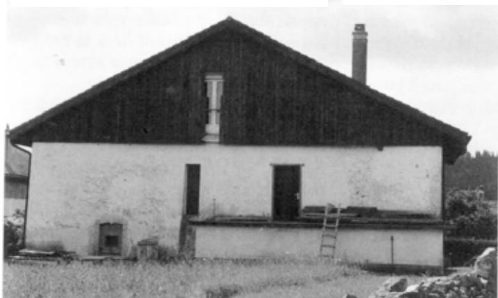
Les Ge.nevez- Façade Nord d'une ancienne ferme. Etat 1991. En bas à gauche, ancienne porte. Dans la façade, trois nouvelles ouvertures accordées par petits permis.
