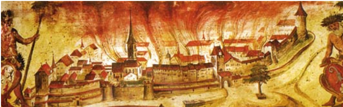
La peinture reproduite ci-dessus est la plus ancienne vue de Delémont. Elle représente l'incendie de 1487. On perçoit clairement au sud-ouest de la cité le fameux château et le châtelet. Les caves voûtées datent de cette époque. On les connaît aussi sous le nom de « caveau ». Aujourd'hui, on y accède par la place Monsieur. Musée jurassien d'art et d'histoire de Delémont.
