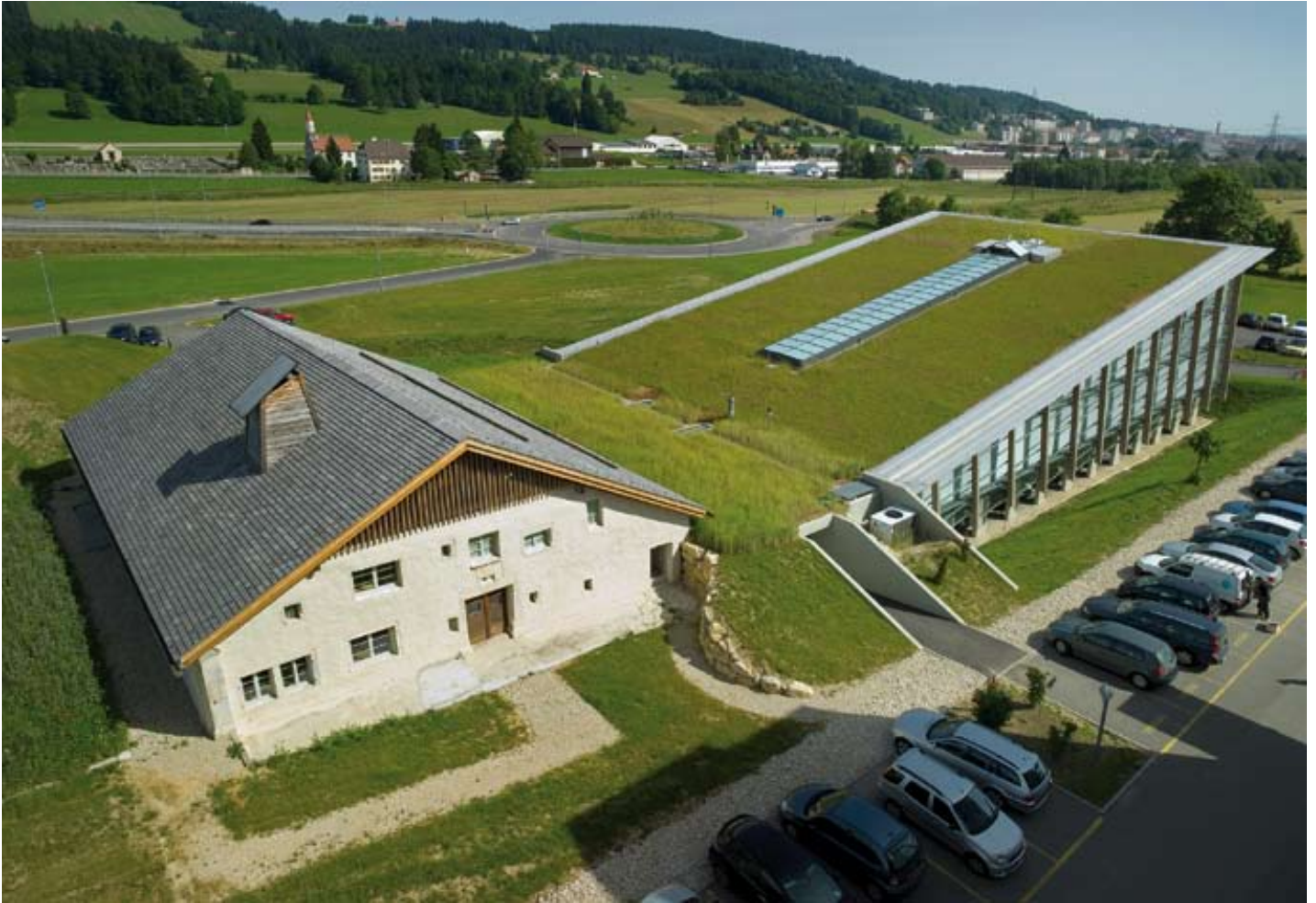
Vue de l'ensemble, prise du toit de l'immeuble voisin.
