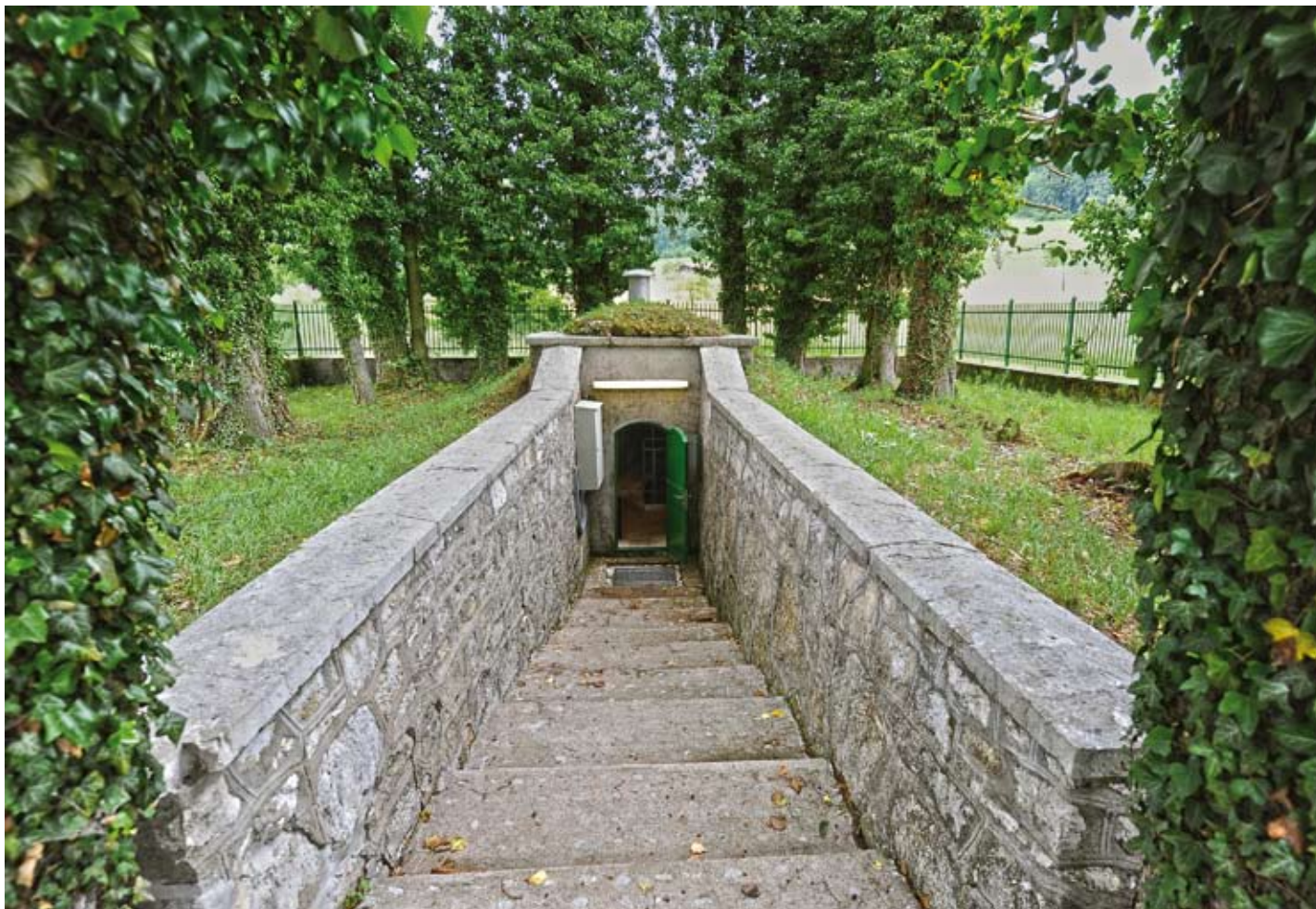
Entrée du captage de la source de l'Ante.
