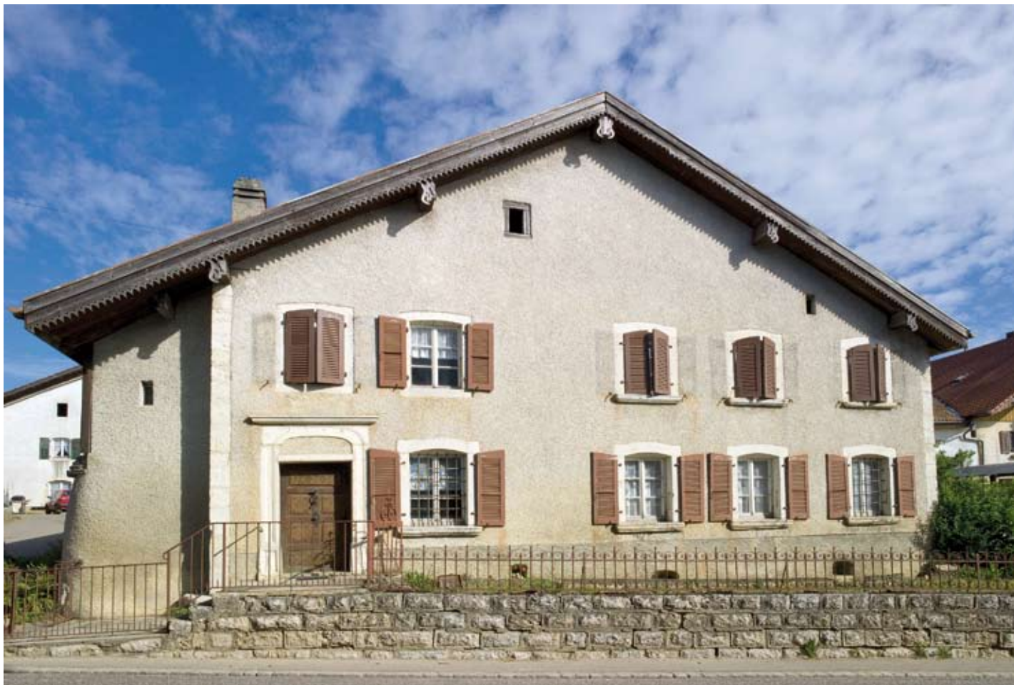
Façade sud de la maison de style XVIII e classique avec fenêtres aux linteaux galbés, flanquée toutefois à l'ouest d'un rajout plus récent d'une valeur discutable.
