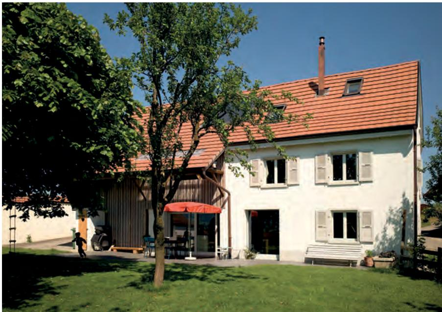
Figure 2: Façade sud, ouverture de deux baies vitrées au rez-de-chaussée.
